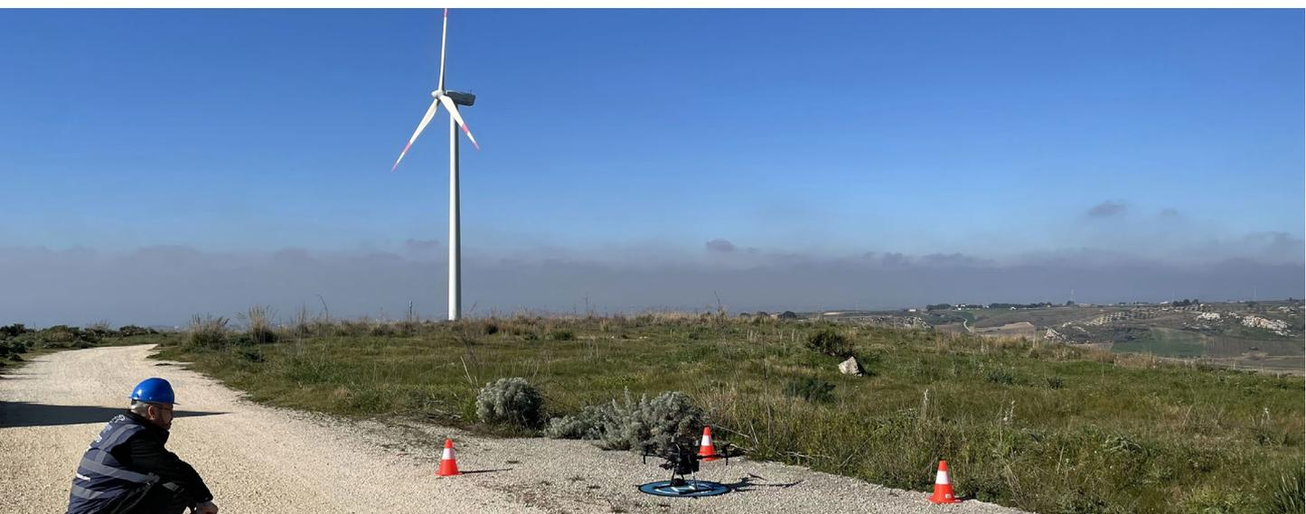
Ispezione delle pale eoliche tramite drone impianto di Lago Arancio - Italia
